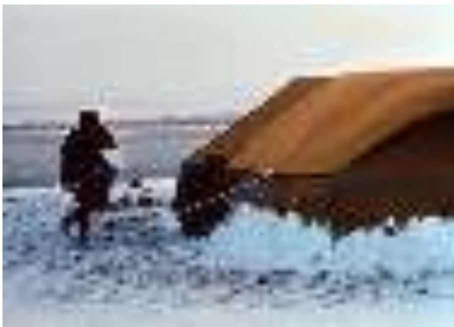
Фото 7. Утепление палатки с помощью снежных кирпичей
