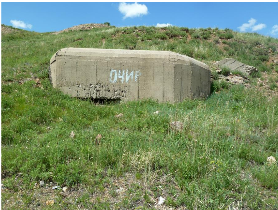
Рис. 4. Современный облик ДОТа в непосредственной близости от подземного штаба
