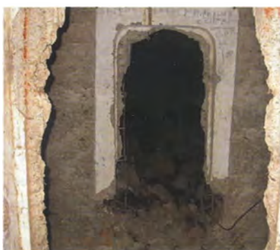
41. Фрагменты фортификационных сооружений 1940-х гг. Фото Г.А. Юргенсона.
